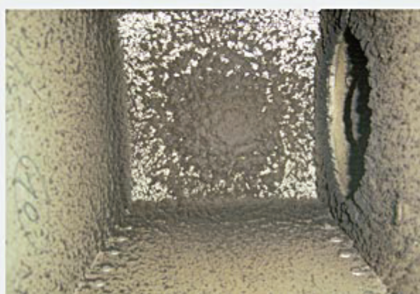
Przykłady zanieczyszczeń elementów instalacji klimatyzacyjno-wentylacyjnej
