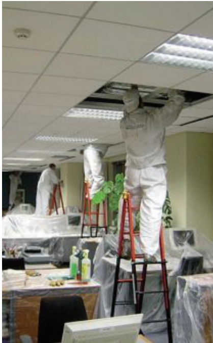
Przygotowanie instalacji do czyszczenia
